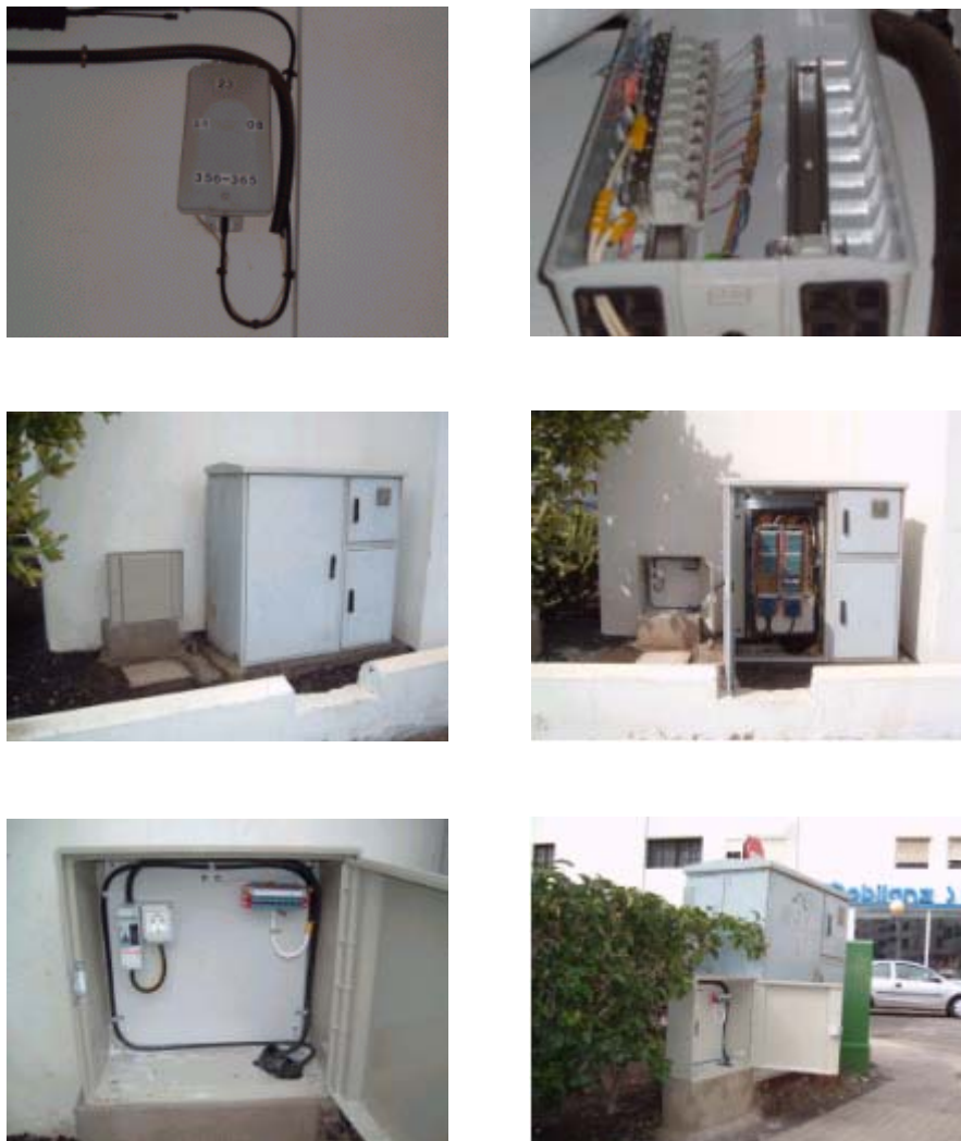
Figura 8. Caja de pares o armario de manzana y armarios de intemperie de INALSA junto a nodos ópticos terminales
