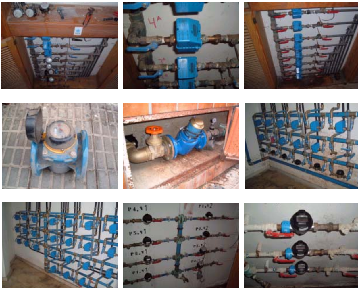
Figura 6. Sustitución de los contadores mecánicos por los digitales
