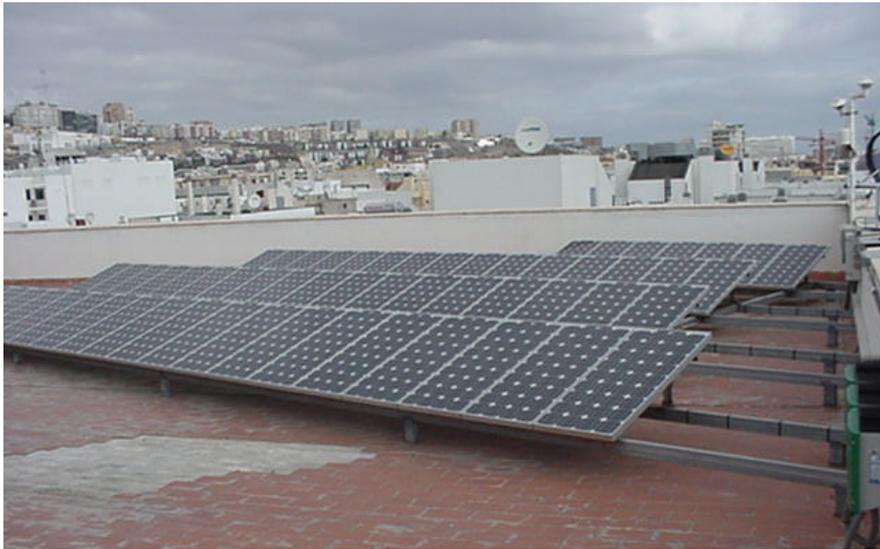
Figura 2. Instalación fotovoltaica de 4,5 kW en la sede del ITC de Las Palmas de G.C.
