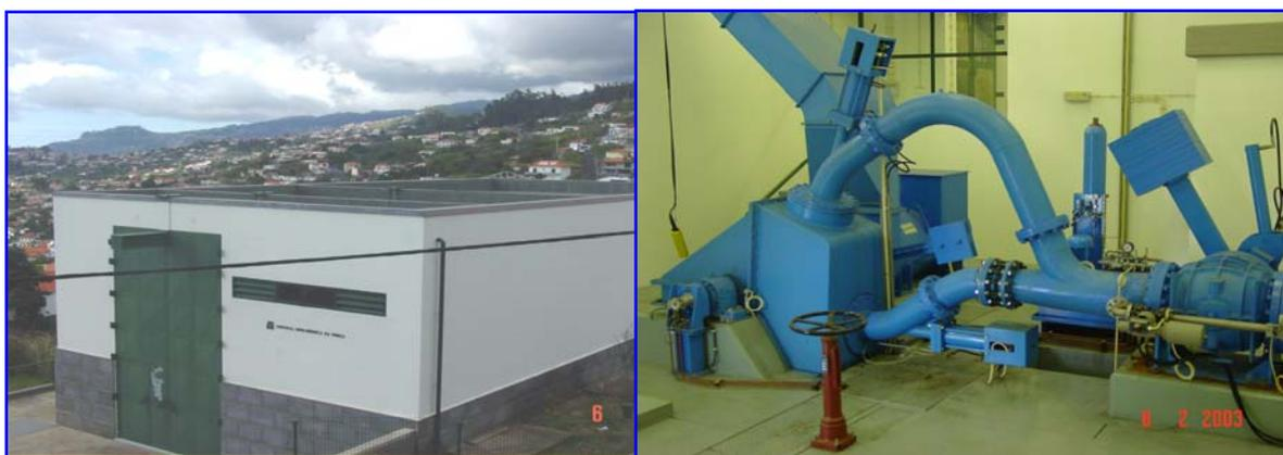
Figura 15 .Minihidráulica de Terça insertada en la red de abastecimiento de aguas de Funchal (Madeira)
