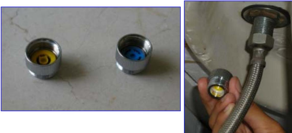
Fig. 5 Limitadores de caudal y adaptación en flexible
