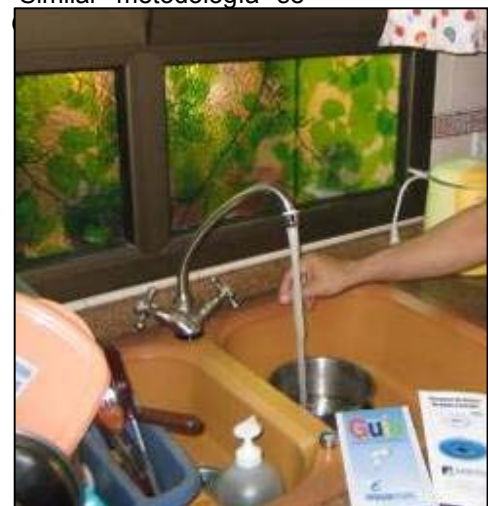
Fig. 4.- Comprobación de la reducción de caudal en una vivienda.
