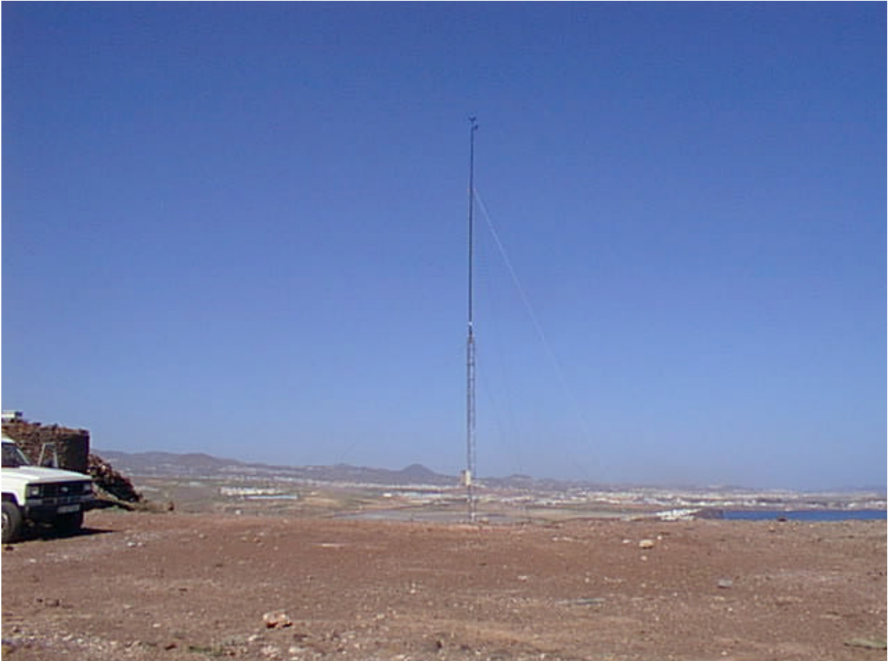
Estación anemométrica de 10 metros de altura perteneciente al ITC
